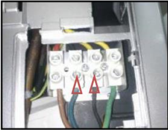
Bild 1: Spannung von N nach S (Vs) prüfen, bewegt sie sich abwechselnd zwischen positivem und negativem Wert?
